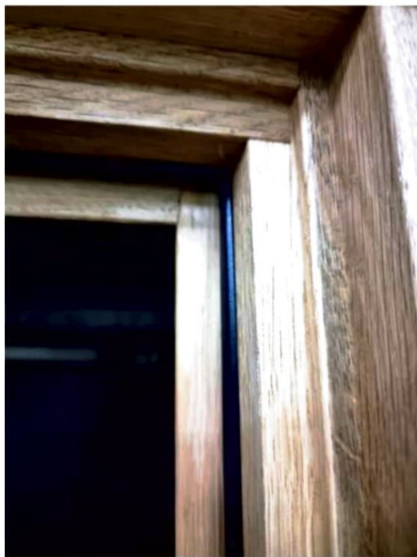
Poza 5 Etansare falt exterior.configurare colt 2
