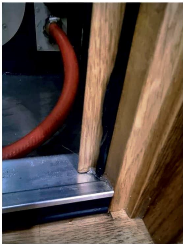
Poza 4 Etansare falt exterior, configurare colt 1
